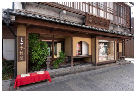
町屋を彷彿とさせる外観。
